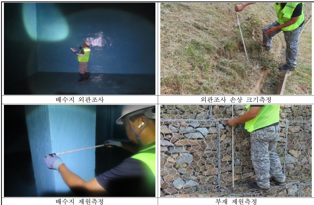
【사진 3.1】 시설물 외관조사
